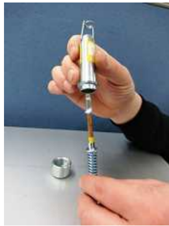
新しいヒューズを差し込み 上部の輪に差し込む
