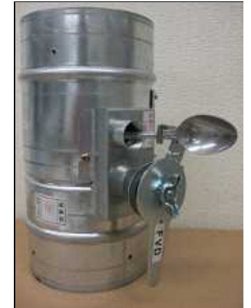
ヒューズが無い場合は緊急処置 としてホルダーを抜きスプーン などでフックに引っ掛けます 可燃物は避けてください 至急ヒューズを取り寄せます
